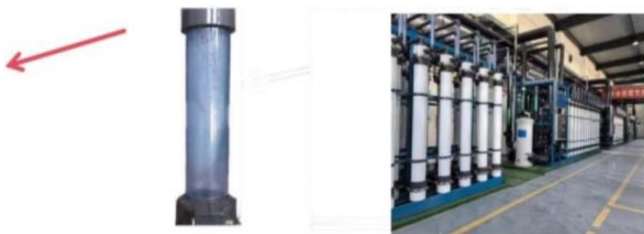
图4-9 浓水透明管示意
