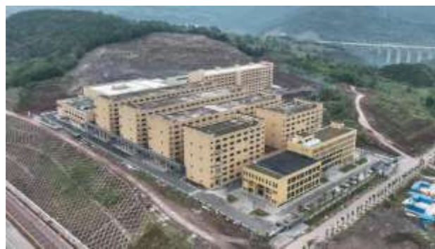
电镀废水零排放(渝东表面处理中心) 处理量3000TPD
