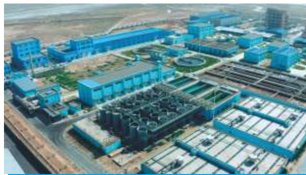
精细化工废水零排放项目 处理量10000TPD
